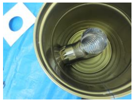
エビ曲の太側を入れる ・穴が小さかったら折り曲げ部分をさらに切り込むなどして調整する。 注)切片での怪我に注意!
